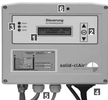
Abbildung 2: Bedien- und Anzeigeelemente der Platinensteuerung
